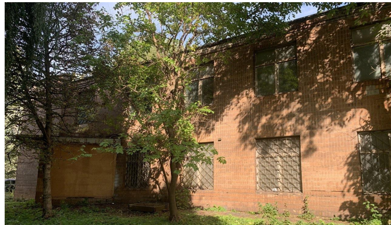
Будівля водогрязелікарні, 893,9 кв.м, вул. Теплична, 18
