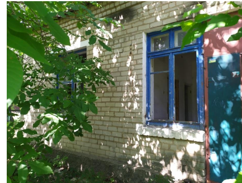
Будівля з підвалом, 116 кв.м, м. Вільнянськ
